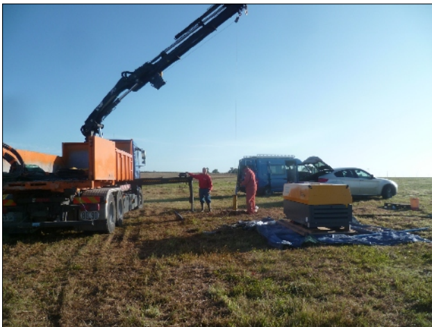
Installations mises en place pour l'essai de pompage
